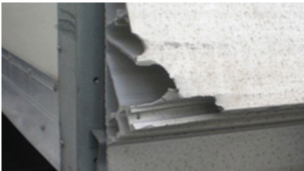
Hayon élévateur: déformations du plateau hors limite économique de la réparation, moulure cassée ou incomplète
