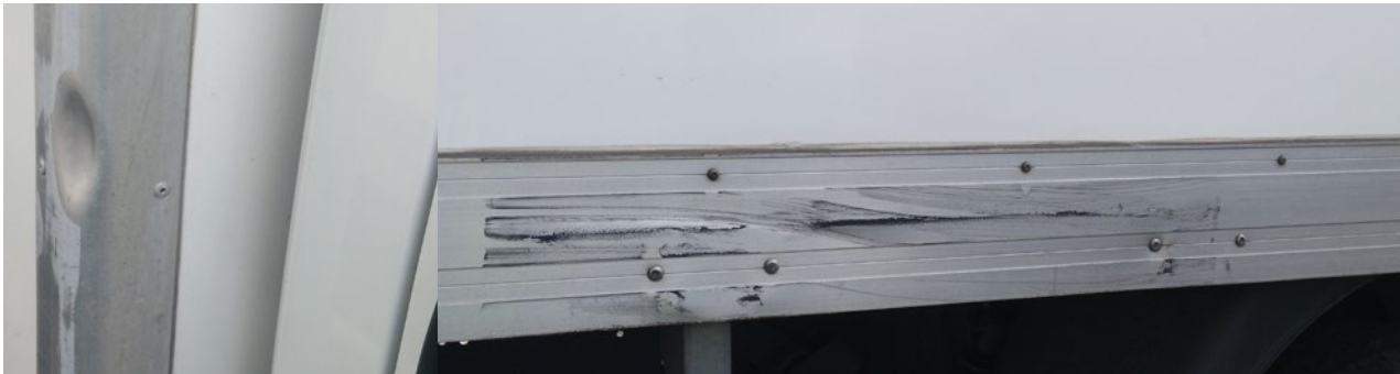
Profilés de rive de caisse: déformations dans la limite économique de la réparation
