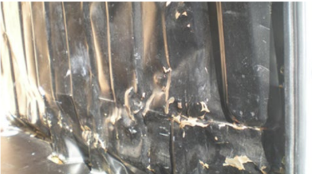
Déformations intérieures: Déformations importantes dont le temps de réparation est > 3h, perforations, découpes
