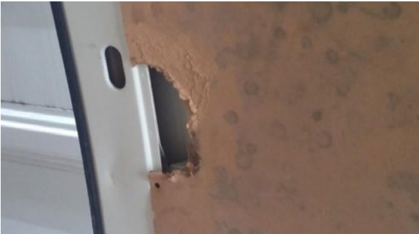
Protections intérieures bois: impacts, déchirement de panneau, absence de panneau (hors panneaux supérieur de portes)
